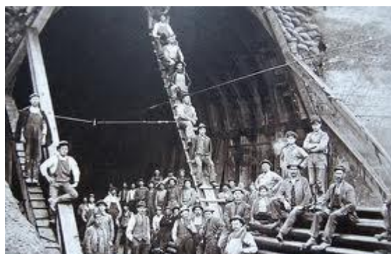
ΗΠΑ, Ντιτρώιτ. Ηπειρώτες μάστοροι σε εργασίες κατασκευής σιδηροδρομικής γραμμής το 1927
